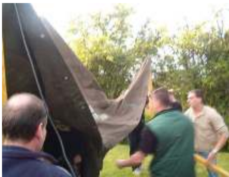
Während des Aufbaus
